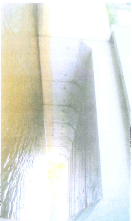
Widok od spodu ustroju mostnego
