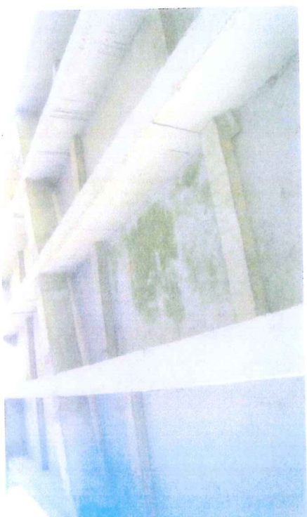
Widok na spód płyty ustroju nośnego
