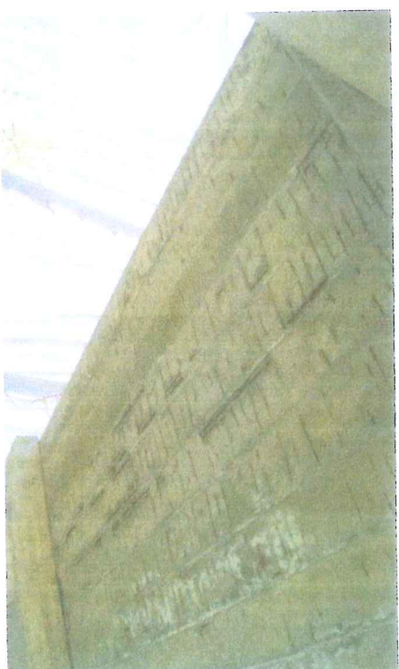
Widok na spód płyty ustroju nośnego
