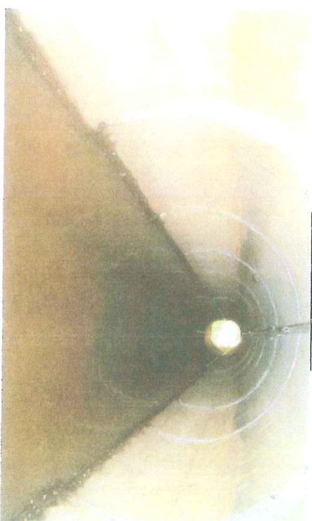
Widok na elementy rurowe
