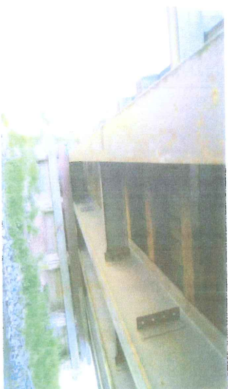
Widok na przyczółek
