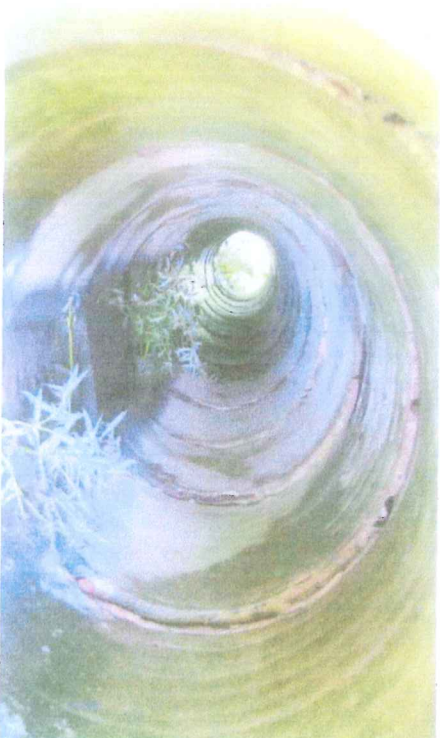
Widok na elementy rurowe
