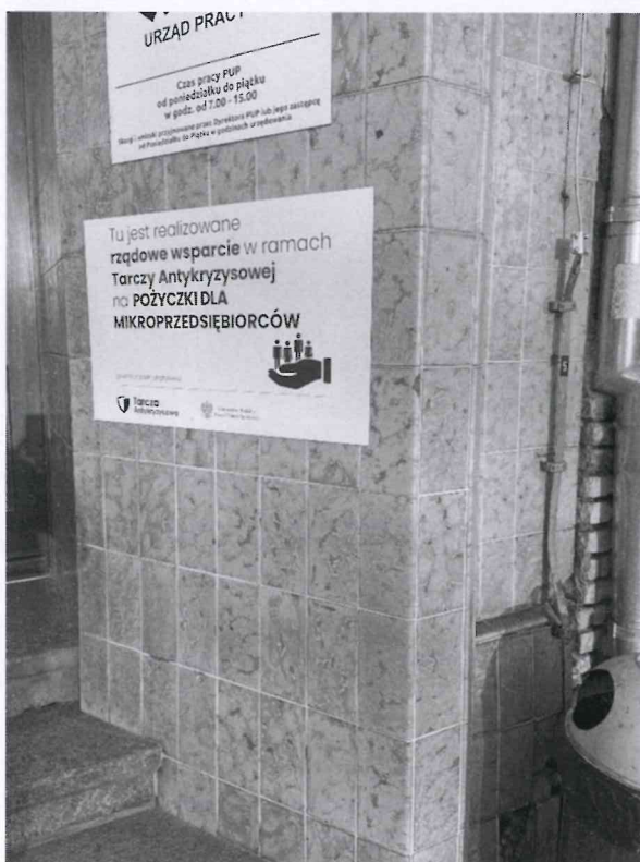
Wejście główne do budynku Płytki ceramiczne przy wejściu Okładzina została założona w czasie prac remontowych w okresie powojennym - przeznaczona do usunięcia.
