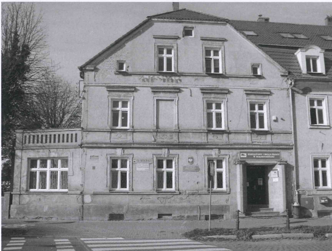
Fragment elewacji południowo- wschodniej
