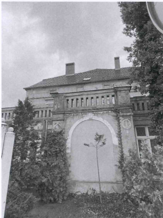
Fragment elewacji południowo- zachodniej –z częścią tarasową nad partem budynku
