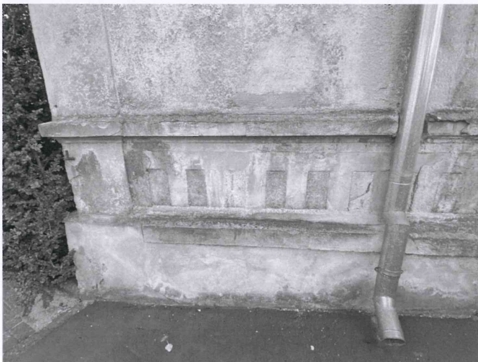
Elewacja południowo-zachodnia – taras
