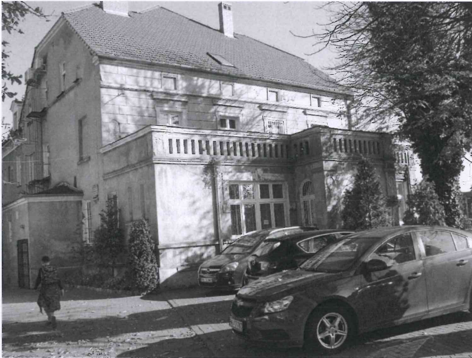
Fragment elewacji południowo- zachodniej
