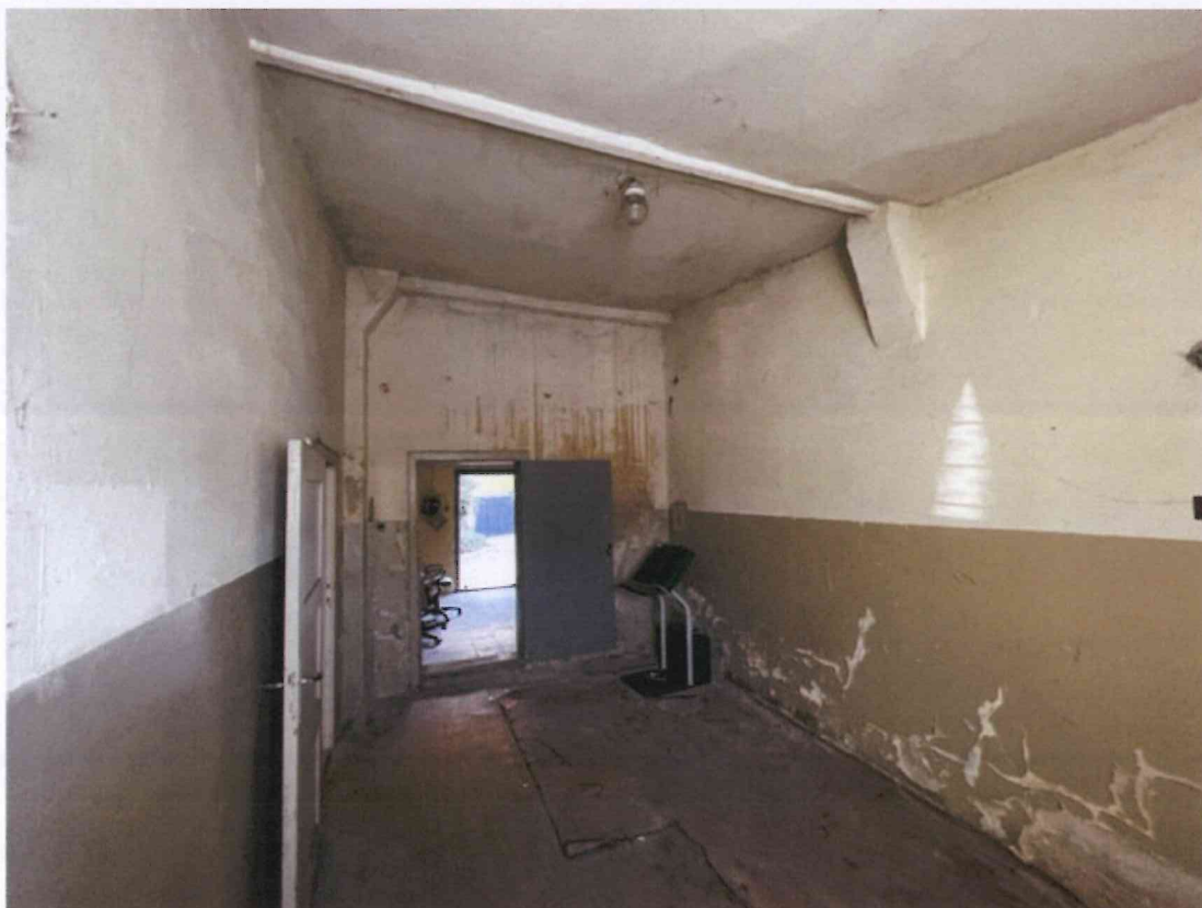
Pomieszczenia gospodarcze – wejście od strony elewacji tylnej budynku
