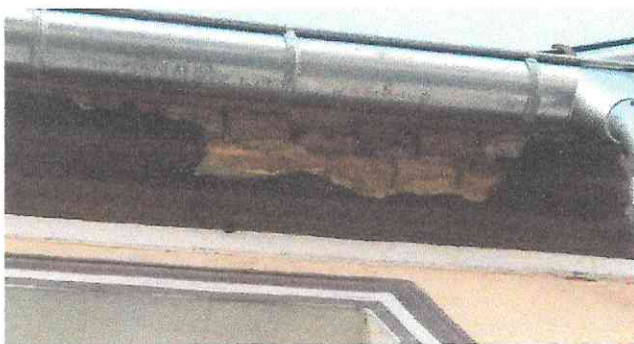
fragment gzymsu koronującego od ulicy
