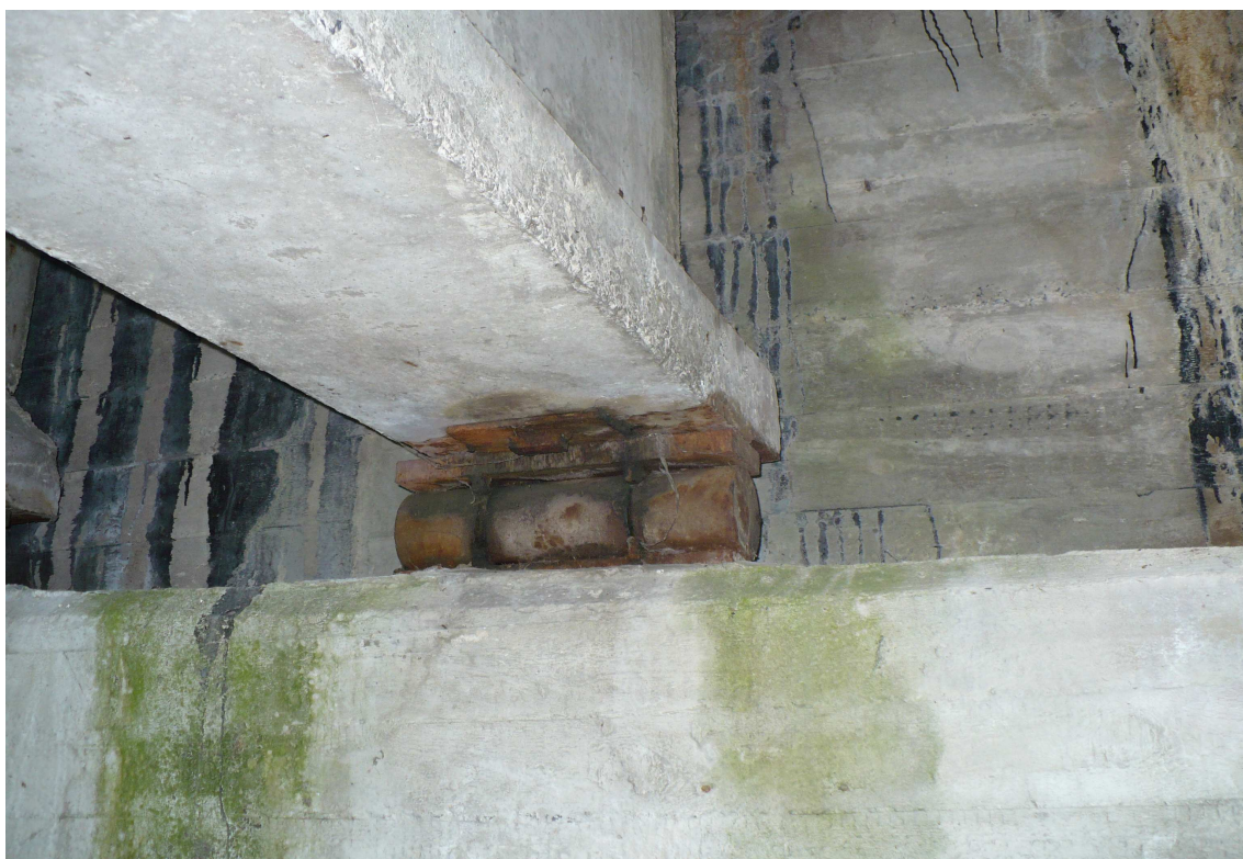
Fot. Nr 12. Górna część ściany przyczółka od strony górnej wody. Widoczne efekty nieszczelności urządzenia dylatacyjnego nad przyczółkiem - białe osady przebarwienia i wilgoć w elementach betonowych. Brak zabezpieczenia antykorozyjnego i korozja elementów łożyska ruchomego.
