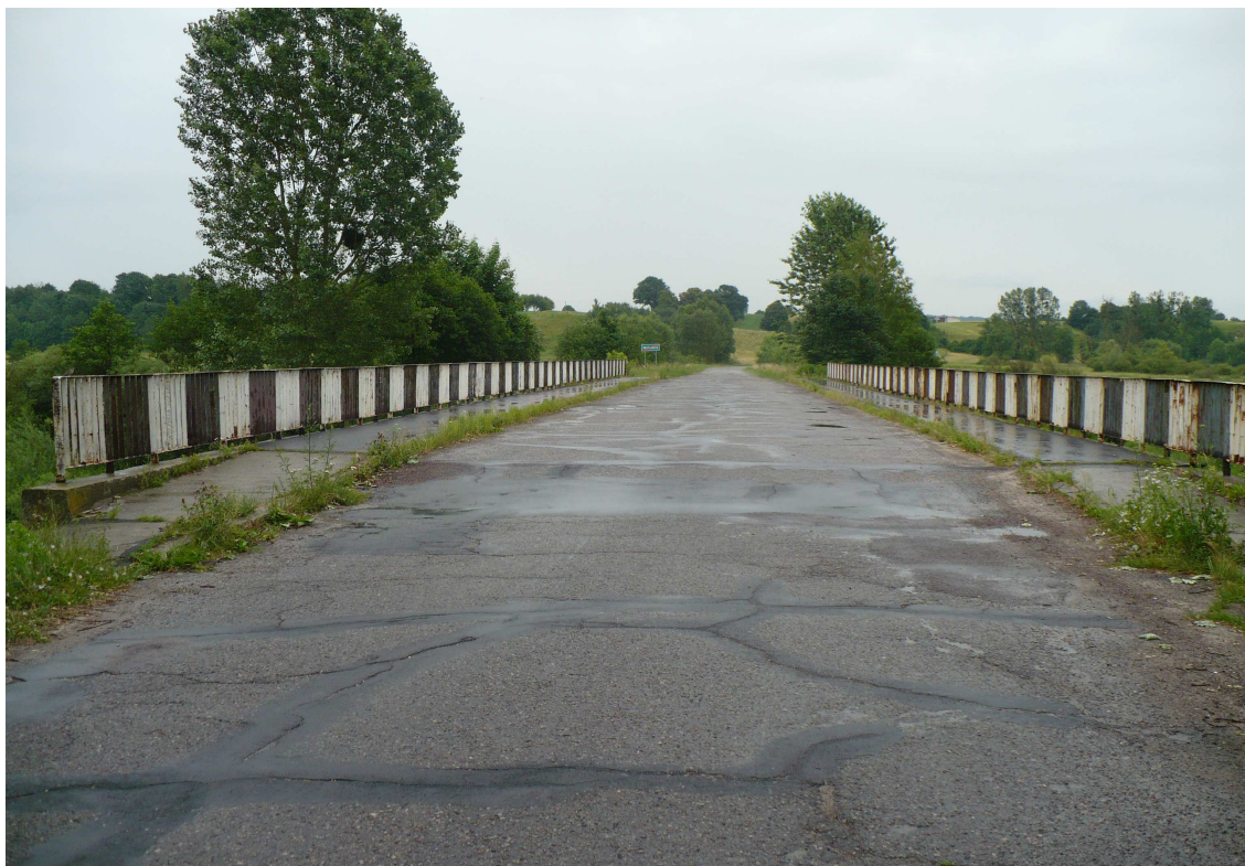
Fot. Nr 1. Widok na most od strony m. Wirkowice. Na obiekcie znajdują się obustronne chodniki dla pieszych. Zabezpieczenie dla ruchu stanowią balustrady o wysokości 1,0m ze słupkami przyspawanymi do marek stalowych, zakotwionych w belkach podporęczowych. Bitumiczna nawierzchnia jezdni na dojazdach z licznymi uszkodzeniami: rysy, ubytki, deformacje.
