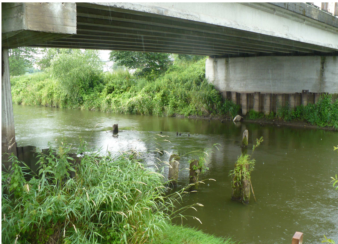
Fot. Nr 22. Koryto rzeki umiejscowione jest pod przęsłem lewobrzeżnym. Znajdują się w nim pozostałości: po poprzednim moście – nieusunięte pale drewniane i z okresu budowy - odcięte końcówki żelbetowych pali posadowienia mostu istniejącego.
