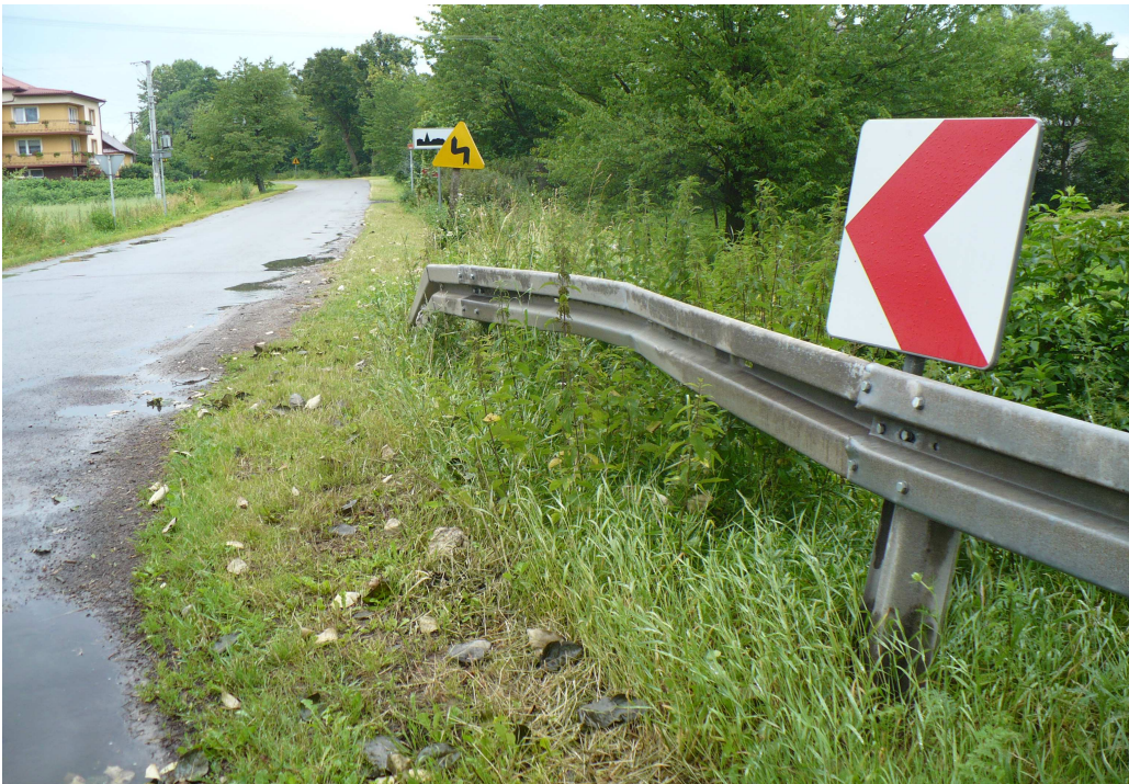
Fot. 2. Bariera, która ma być elementem zabezpieczenia ruchu. Taśma bariery zdeformowana w wyniku uderzenia pojazdu. Słupki bariery stanowią części taśmy wbitej w grunt. Zakończenie bariery wykonane w sposób niekatalogowy.
