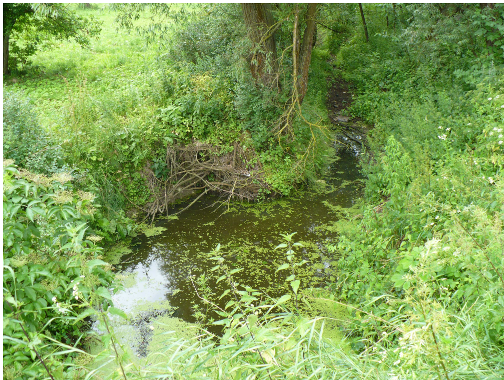
Fot. 9. Widok na rozlewisko powstałe po stronie wylotu przepustu.
