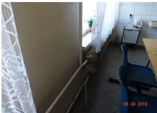
stare grzejniki i niezaizolowane przewody
