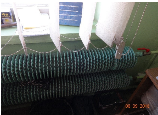
stare grzejniki i niezaizolowane przewody
