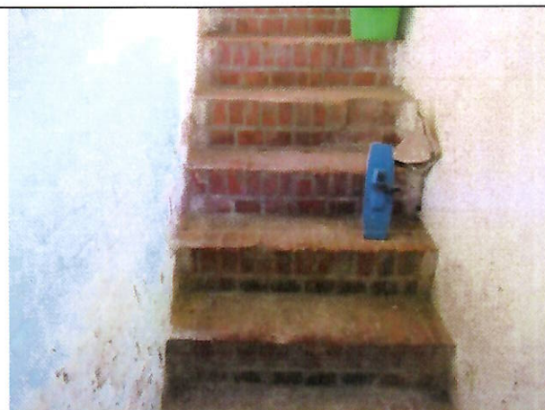
schody ceglane do piwnicy
