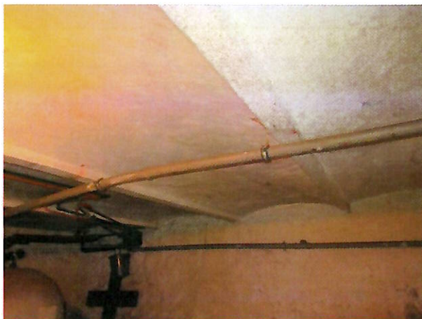
STROPY NAD PARTREM z DESKOWANIEM PODŁOGI PODDASZA Widoczne belki stalowe, poprzecznie ułożone w stosunku do długości budynku.
