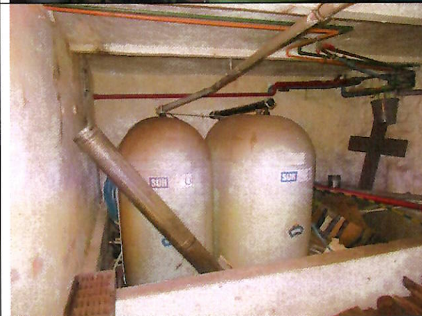
zbiorniki z PCV na olej opałowy-nie używane
