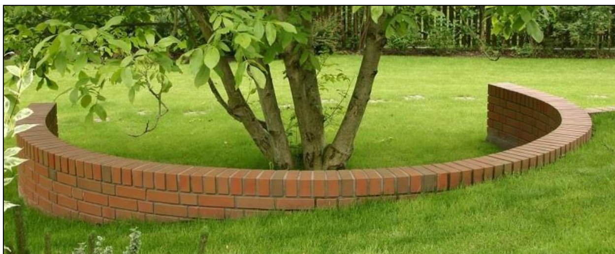
Ryc. 8 Przykładowe zdjęcie murka klinkierowego, wbudowanego w skarpe
