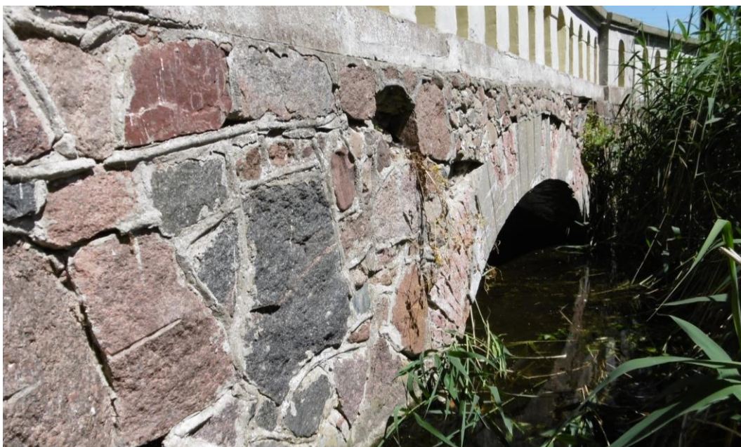
Fot. 4. Widok obiektu od strony południowo-wschodniej (widoczne wcześniejsze naprawy sklepienia ceglanego).
