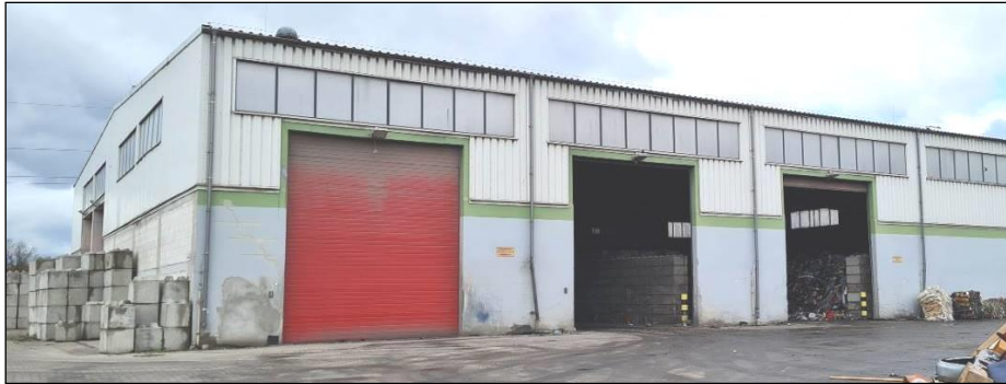
Istniejąca hala sortowni
